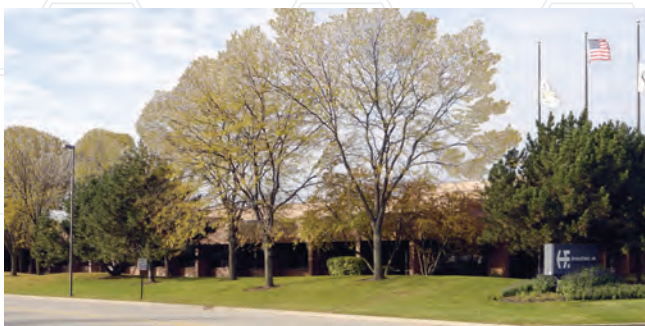
FIRMENSITZ, KONSTRUKTIONS- UND FERTIGUNGSBETRIEB IN LINCOLNSHIRE, ILLINOIS, USA, NÖRDLICH VON CHICAGO.
